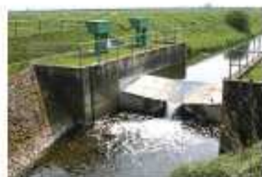
ایستگاه اندازه‌گیری آبدهی رود
